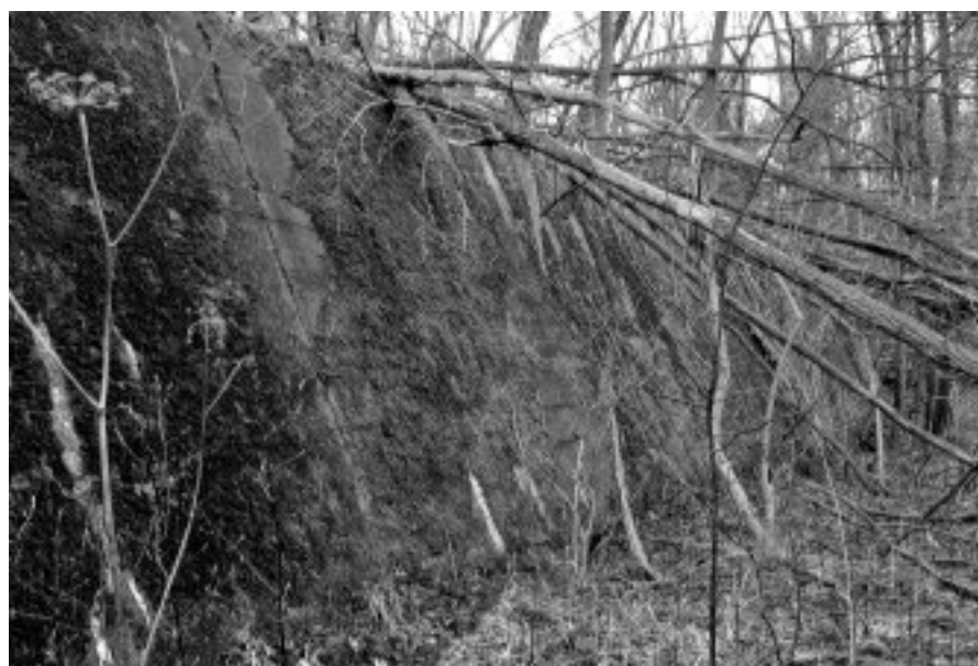
Abb. 2.: Das Westwallbauwerk im Wald zwischen Berg und Hagenbach ist dicht von Moosen bewachsen. Hier befindet sich der bisher einzige Nachweis des Zarten Kleinschnabeldeckelmooses in der pfälzischen Rheinebene.
